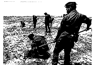
道路を補修する際に、地雷などの探知を行う自衛隊員
